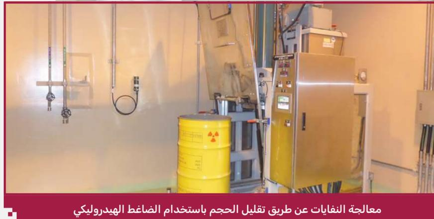
معالجة النفايات عن طريق تقليل الحجم باستخدام الهيدروليكي
